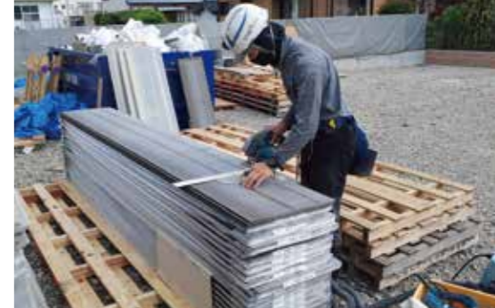
外壁工事②
